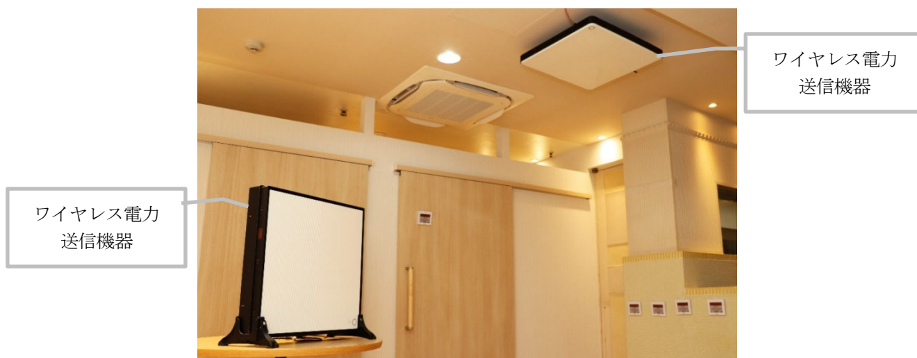
空間伝送型ワイヤレス電力伝送システム Cota デモルーム
