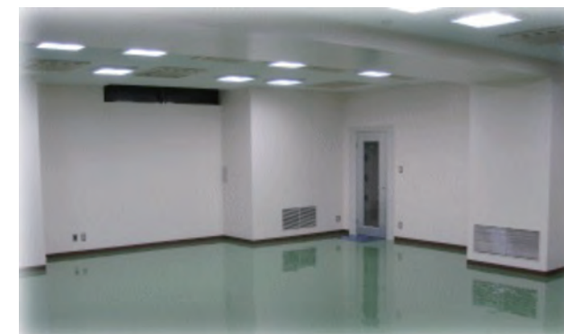
クリーンルーム(100m 2 /クラス100)
